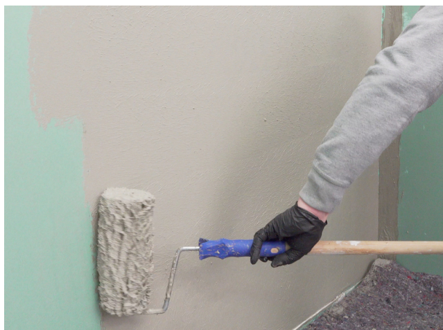
Für ein gleichmäßig deckendes Ergebnis Sopro Fixier- & DichtKleber oder Sopro DichtSchlämme Flex RS im Kreuzgang auftragen.
