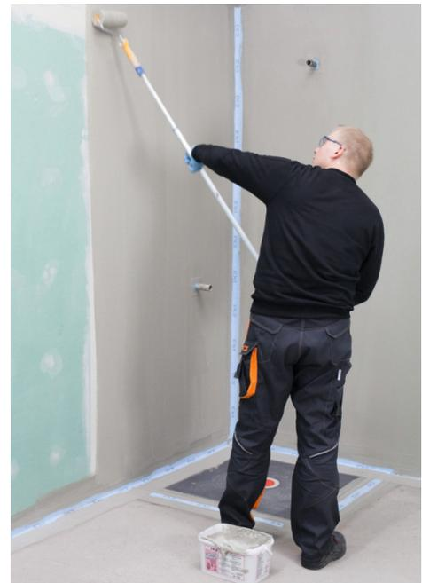
PCI Lastogum Dicht wird unverdünnt durch Rollen, Streichen oder Spachteln auf den Untergrund aufgebracht.
