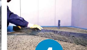
4 Auf gewünschter Höhe auftragen, verteilen, abziehen – fertig!
