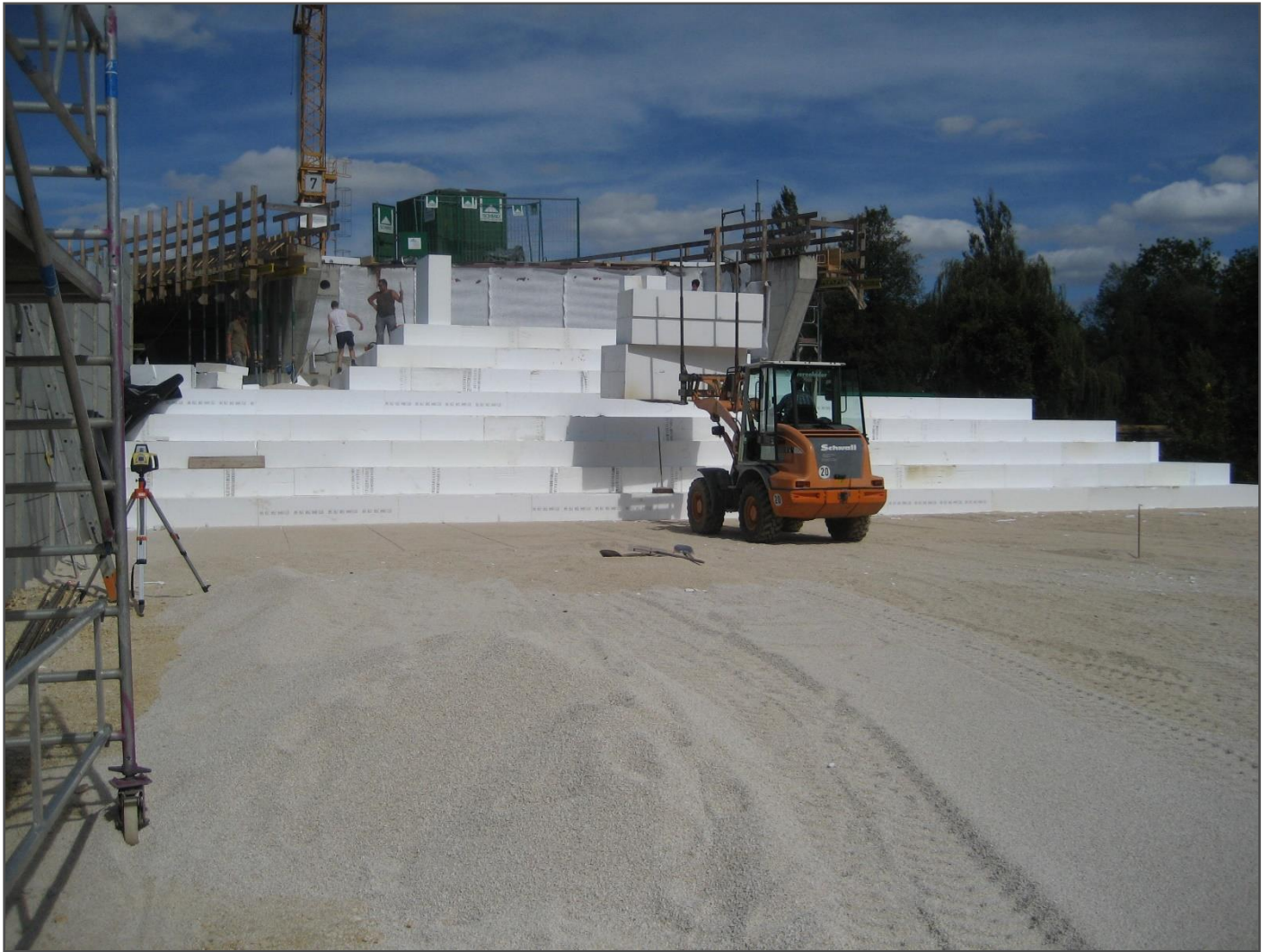
(Fotos als Beispiel: Straßenbauprojekt in Blaustein bei Ulm, 2011)
