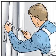
**6.** In Ecken und an Kanten Tapetenbahn abtrennen und nachfolgende Bahn auf Stoß tapezieren.
