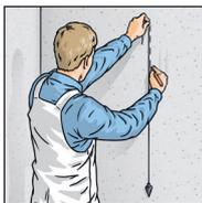
**3.** Die Bahnen Naht an Naht im Lot verkleben.
