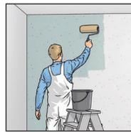
**2a.** In Wandklebetechnik ohne Weichzeit zu verarbeiten. Dafür den Kleister, Bahn für Bahn, gleichmäßig auf den Untergrund aufgetragen und die ERFURT-Vlies-Rauhfaser trocken in das Kleisterbett einlegen.
