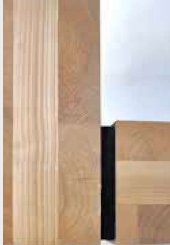
Wand-Deckenverbindung mit SonusStripe
